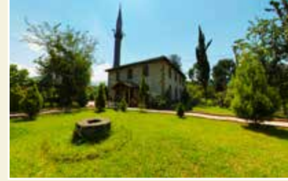
Uğurlu Köyü Yeni Meze Camii
