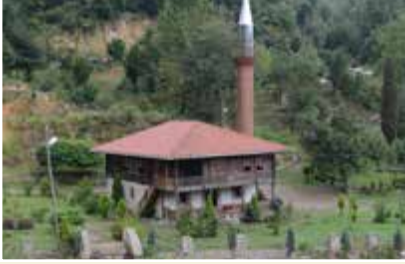
Hemşin Köyü Camii
