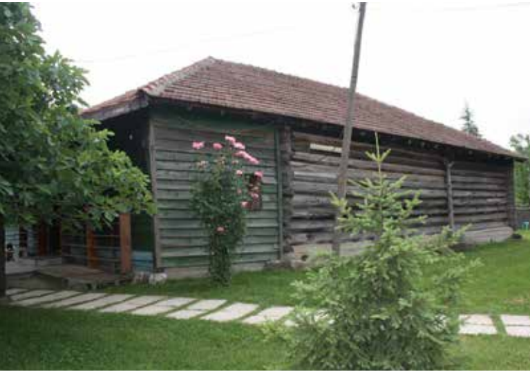
Kaynaşlı Sarıçökek Köyü Orhangazi Camii
