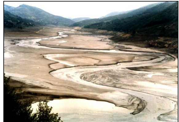
Şekil 28. Hasanlar Baraj Gölü Tabanında Yoğun Sedi-mantasyon. 1996 yılında bakım için suların boşaltılmasıyla ortaya çıkan görüntü. Vadi yamaçlarında ormanların azaltılması erozyonu artırmakta ve suların getirdiği çökelti barajda birikerek, barajın doğal ömrünü kısaltmaktadır (Karagül, 1998c).
