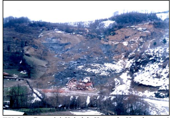
EK 31. Boğaziçi Kabalak Köyünde Heyelan ve 4 Katlı Bir İlköğretim Binasının Yıkılması (Foto R. Karagül, 21.02.1997).
