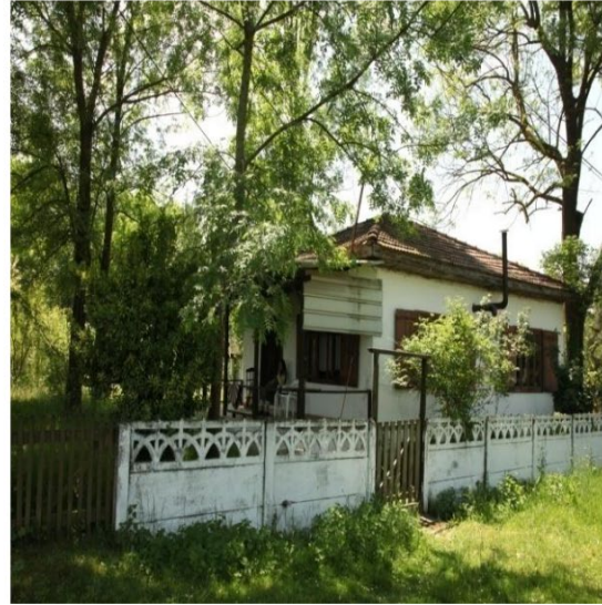
Fotoğraf 44: Evin bahçe duvarından genel görünüş (Düzce Merkez, Duraklar Köyü)
