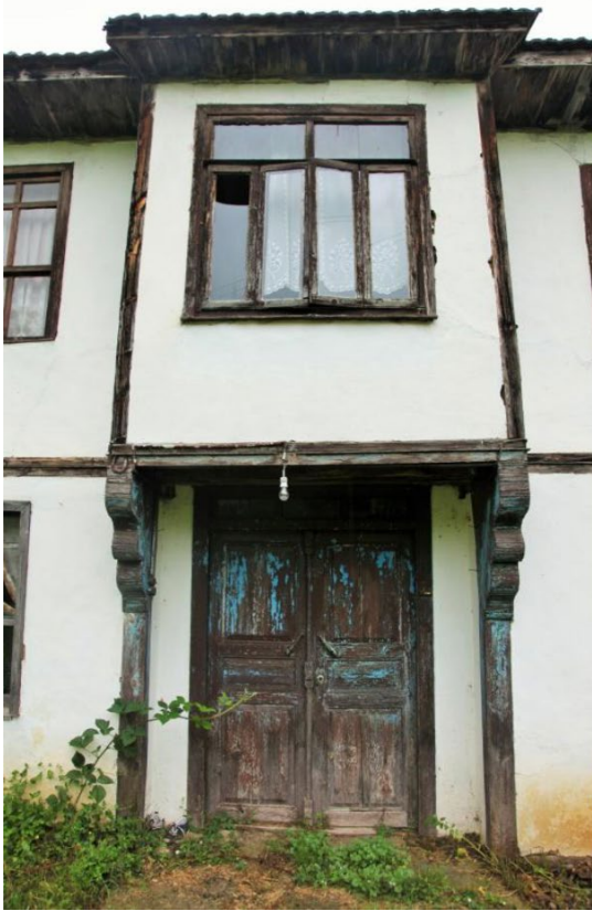
Fotoğraf 24: Geleneksel ahşap konutun ön cephesindeki giriş kapısı ve Cumba kısmı (Kaynaşlı İlçesi, Saz Köyü)
