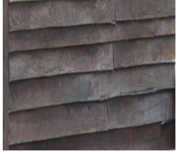
Fotoğraf 6: Ahşap karkas yapının bedevra/hartama kaplamalı dış duvarı (Akçakoca İlçesi, Yukarı Mahalle)
