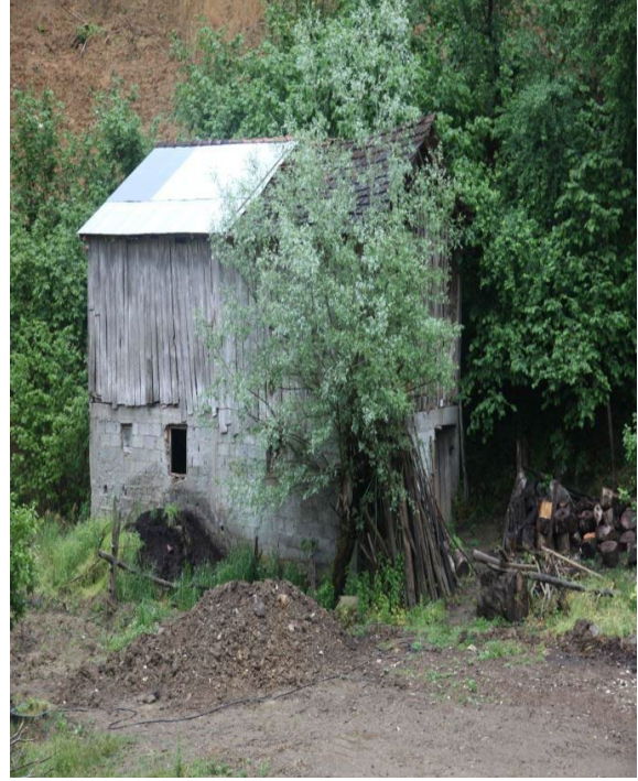
Fotoğraf 48: Ahır ve samanlık (Cumayeri İlçesi, Dokuz Değirmen Köyü)
