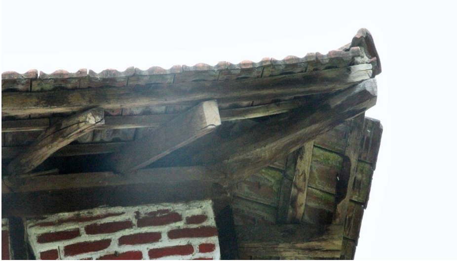
Fotoğraf 33: Ahşap konutun saçak kısmı (Çilimli İlçesi, Esenli Köyü)
