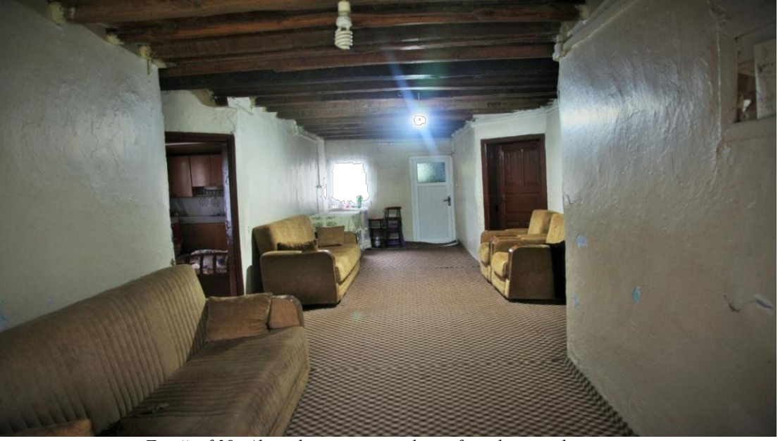
Fotoğraf 38: Ahşap konutun zemin kat sofasından genel görünüş (Cumayeri İlçesi, Dokuz Değirmen Köyü)
