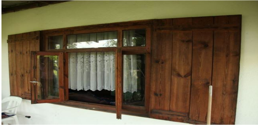
Fotoğraf 23: Evin giriş katındaki ahşap pencere ve kapakları (Düzce Merkez, Duraklar Köyü)
