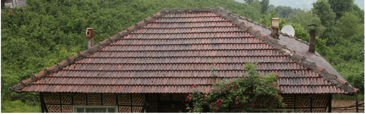
Fotoğraf 10: Kıрма çatı (Gölyaka İlçesi, Saçmalıpınar Köyü)
