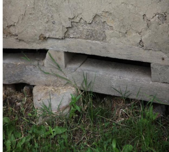
Fotoğraf 2: Evin temel taşı ve hatıllar (Çilimli İlçesi, Esenli Köyü)
