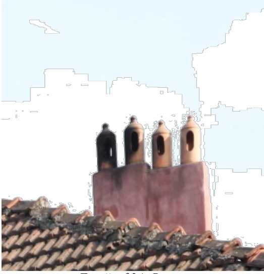
Fotoğraf 34: Baca (Düzce Merkez, Üç Yol Köyü)
