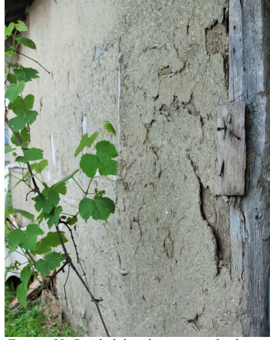
Fotoğraf 9: Bağdadi harçla sıvanmış dış duvar (Çilimli İlçesi, Esenli Köyü)
