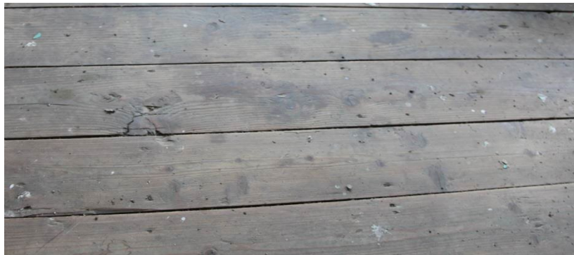
Fotoğraf 12: Oda tabanının ahşap yer döşemesi (Çilimli İlçesi, Topçular Mahallesi)
