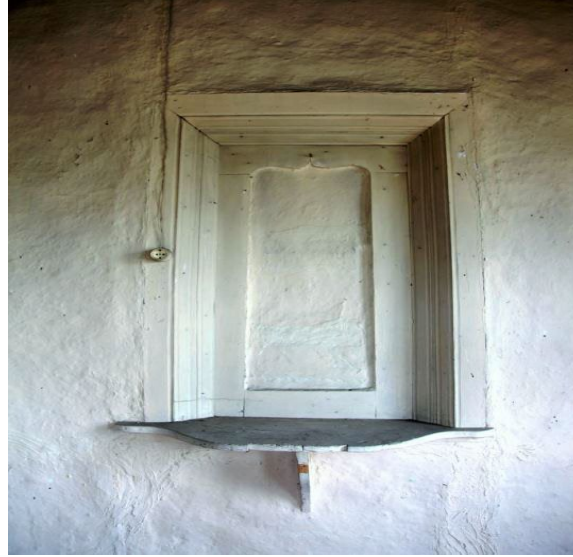
Fotoğraf 60: Oda duvarında yer alan niş ve lambalık (Çilimli İlçesi, Topçular Mahallesi)
