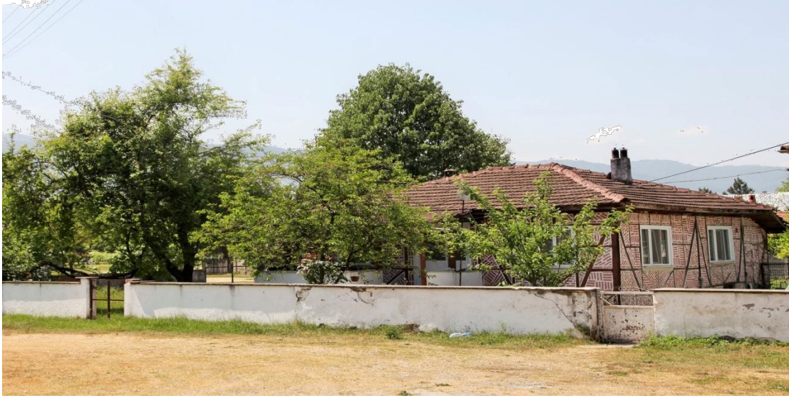
Fotoğraf 45: Evin bahçe duvarından genel görünüş (Düzce Merkez, Duraklar Köyü)
