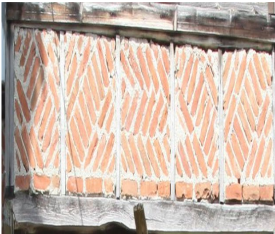
Fotoğraf 3: Ahşap karkas yapının tuğla dolgulu dış duvarı (Gümüşova İlçesi, Dere Köyü)
