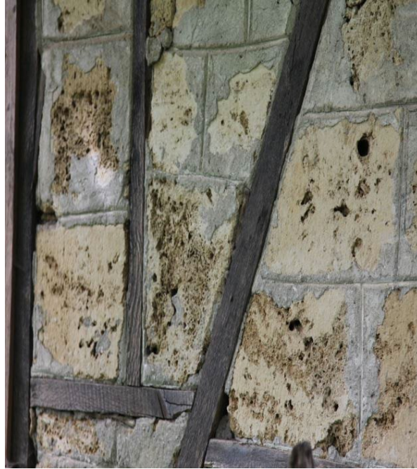
Fotoğraf 7: Ahşap karkas yapının süngüt taşı dolgulu dış duvarı (Gümüşova İlçesi, Dere Köy)
